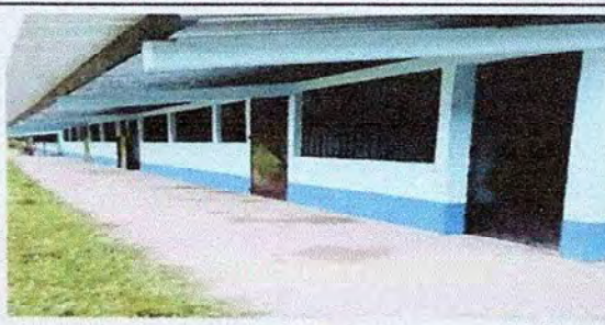
Foto 5: finalización de mantenimiento a estructura de puertas de metal (lijado, cambio de tubo, cepillado y aplicación de pintura).
