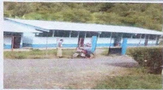
Foto 2: Entechada edificio No. 2 finalizada
