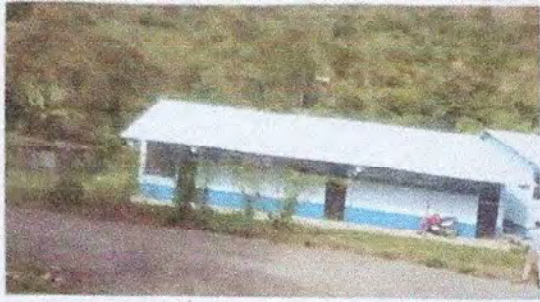
Foto 1: Entechada edificio No. finalizada
