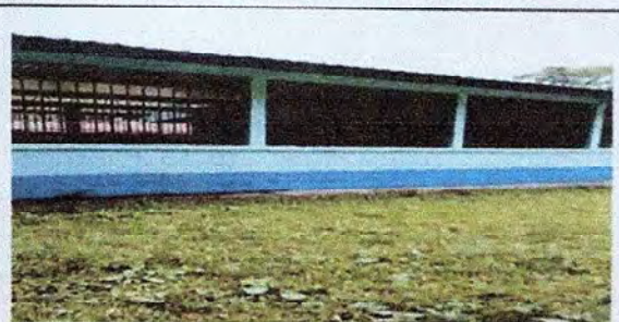
Foto 6: Finalizacion de mantenimiento de pintura de balcones de metal.
