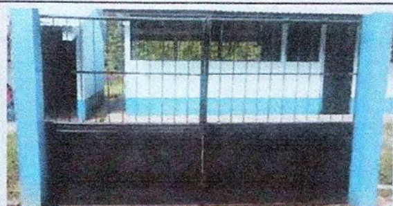
Foto 4: sustitución de porton de metal finalizada.
